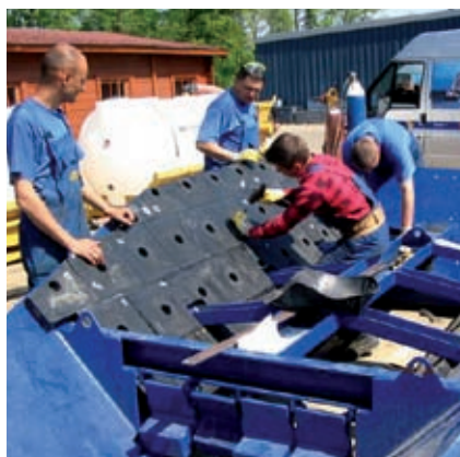
Небольшая масса плит WT7000 облегчает монтаж
